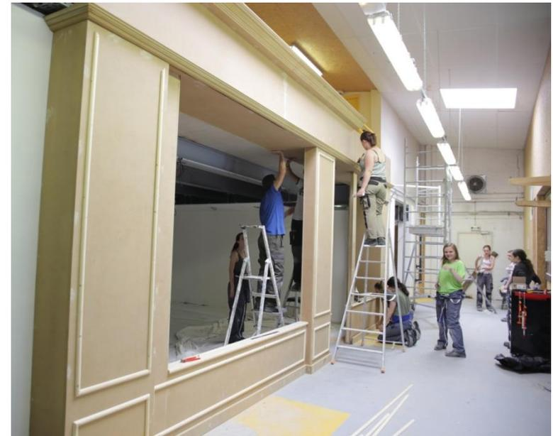
**Chantier de pose et d'installation d'une façade de magasin réalisée par les élèves de terminale.**
